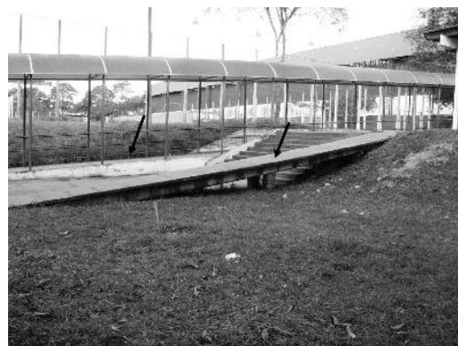
Figura 1. Rampas de acesso externo ao piso inferior do ginásio de treinamento.
